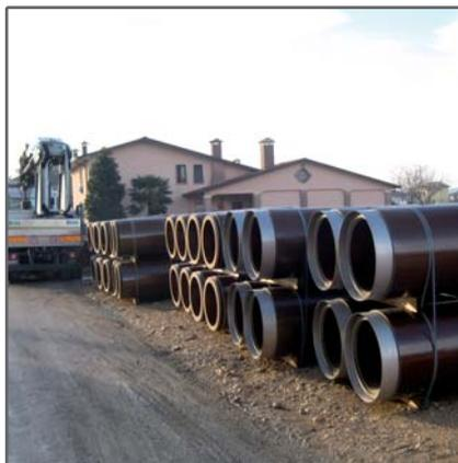
Fig. 4 - Tubazioni in Gres DN 600mm
