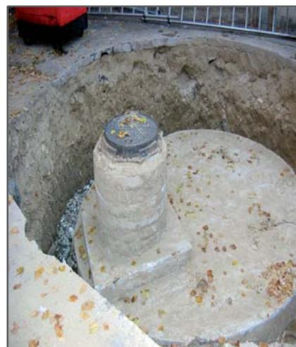
Fig. 6 - Fase terminale posa pozzetto con passo d'uomo
