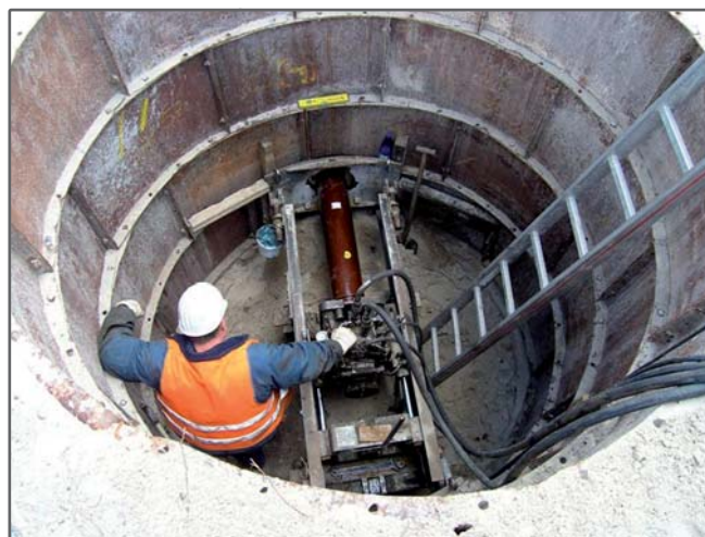
Fig. 2: Posa a spinta di condotte di allacciamento domestico partendo dal pozzetto ausiliare
