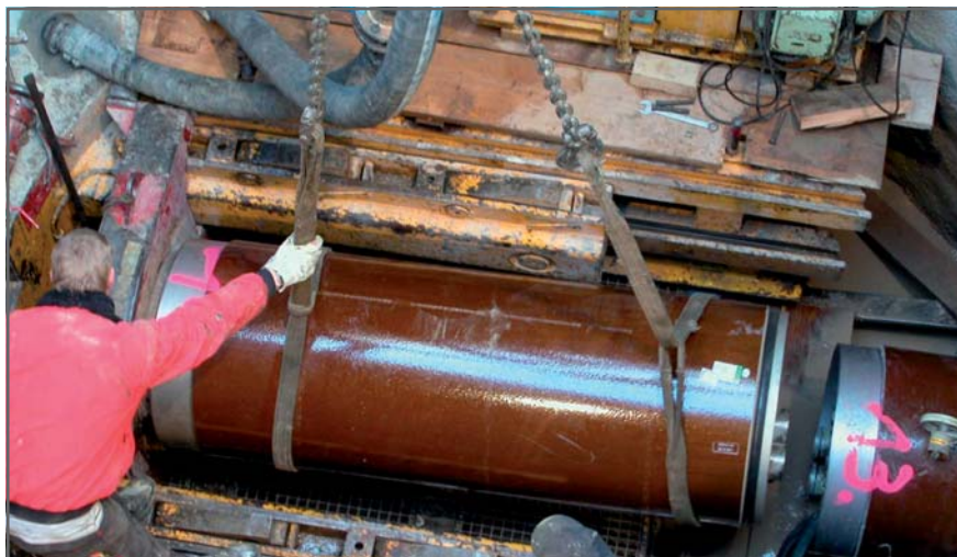
Fig. 8: Avanzamento a spinta con tubo di Gres
