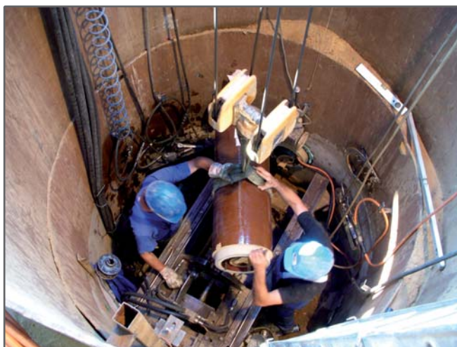
Fig. 1: Macchina a spinta al lavoro
