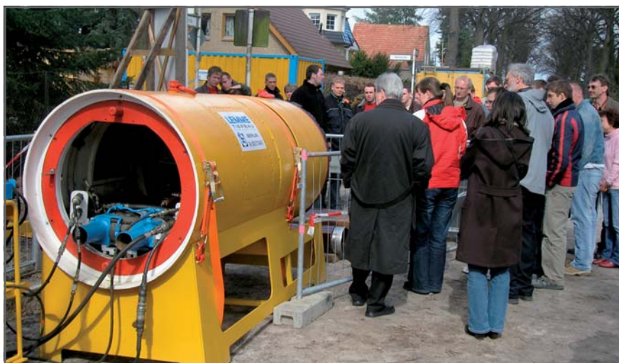
Fig. 9: Congresso WASSER BERLIN 2009: visitatori in un cantiere berlinese durante la giornata dei cantieri aperti.
