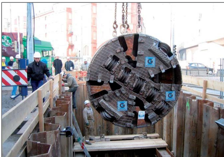
Fig. 3: Preparazione: la Macchina a spinta tipo AVN 1600 T viene calata nel pozzetto di spinta.
