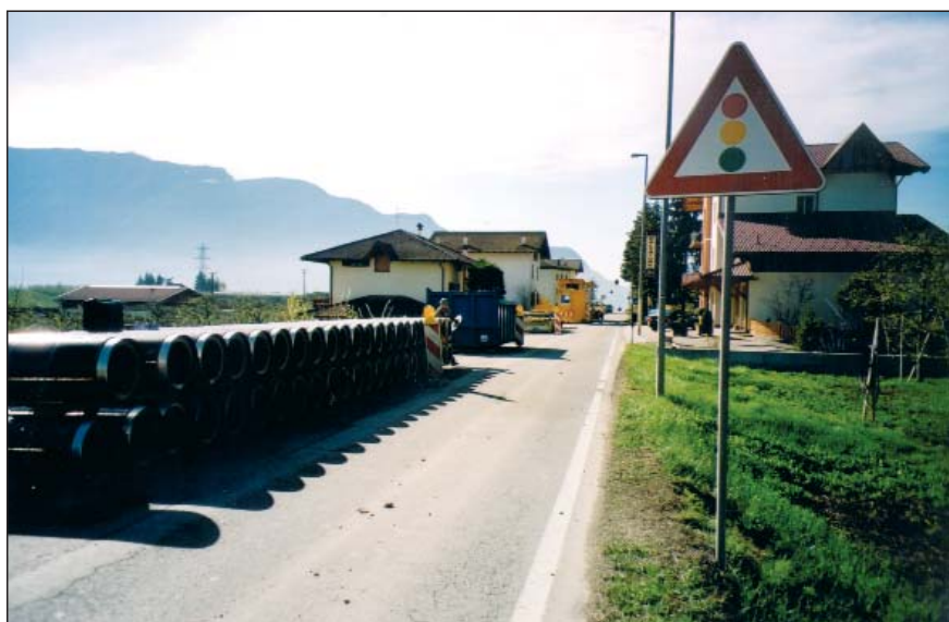
• per la realizzazione del microtunnel sono stati utilizzati tubi in gres rinforzato della serie speciale.
