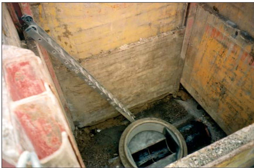
• completata la trivellazione, nei pozzi sono state predisposte le camerette di ispezione.
