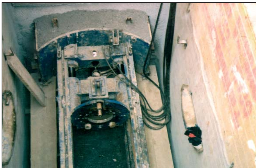
• pozzo di spinta nel quale la trivella, avanzando, trascina con sé i tubi in gres.
