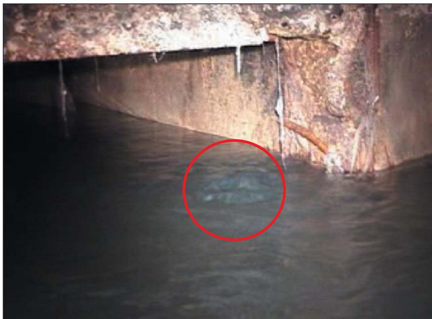
• Esempio di infiltrazione in una botte a sifone (60-90 l/s misurati).
