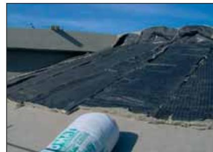
tazione si è resa necessaria per mantenere all'interno dei digestori una temperatura più elevata e quindi un biogas a potere calorifico più elevato con conseguente maggiore recupero energetico;
