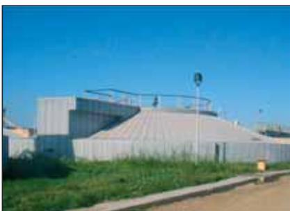
Il ripristino della resistenza strutturale è stato l'intervento più qualificante in quanto ha permesso il recupero funzionale di una struttura obsoleta che altrimenti sarebbe dovuta essere demolita. Il recupero statico è stato ottenuto mediante precompressione con cavi in acciaio (fig. 1) protetti da doppia guaina in polietilene, ancorati in una lesena in calcestruzzo (fig. 2) resa solidale alla struttura dei digestori, posizionati nella parte cilindrica dei digestori, e costituenti
