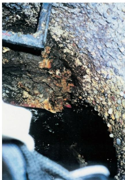
• Figura 5: corrosione da acido solforico biochimico in un pozzetto
