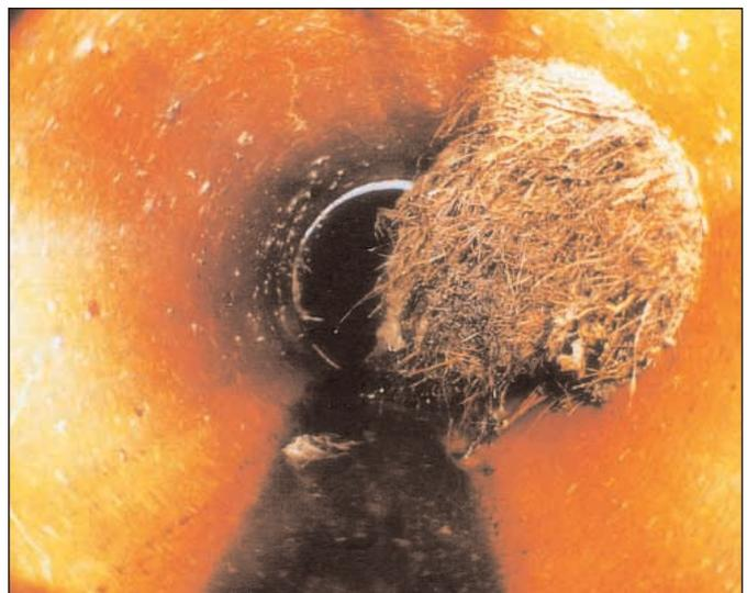
• Esempio di condotta con intrusione di radici
