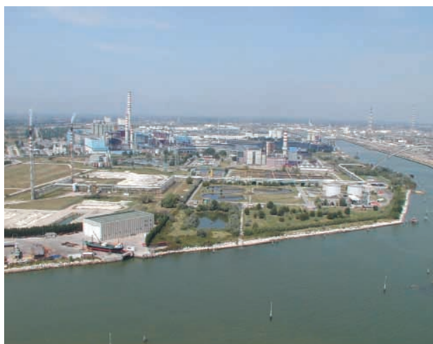
• Impianto di depurazione a tecnologia complessa
