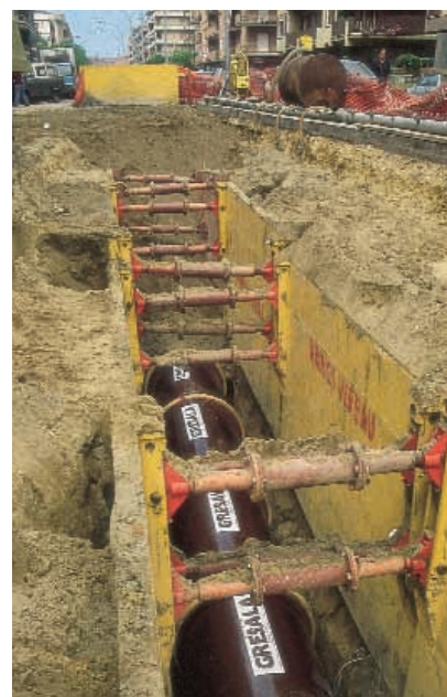
• Cantiere di fognature
