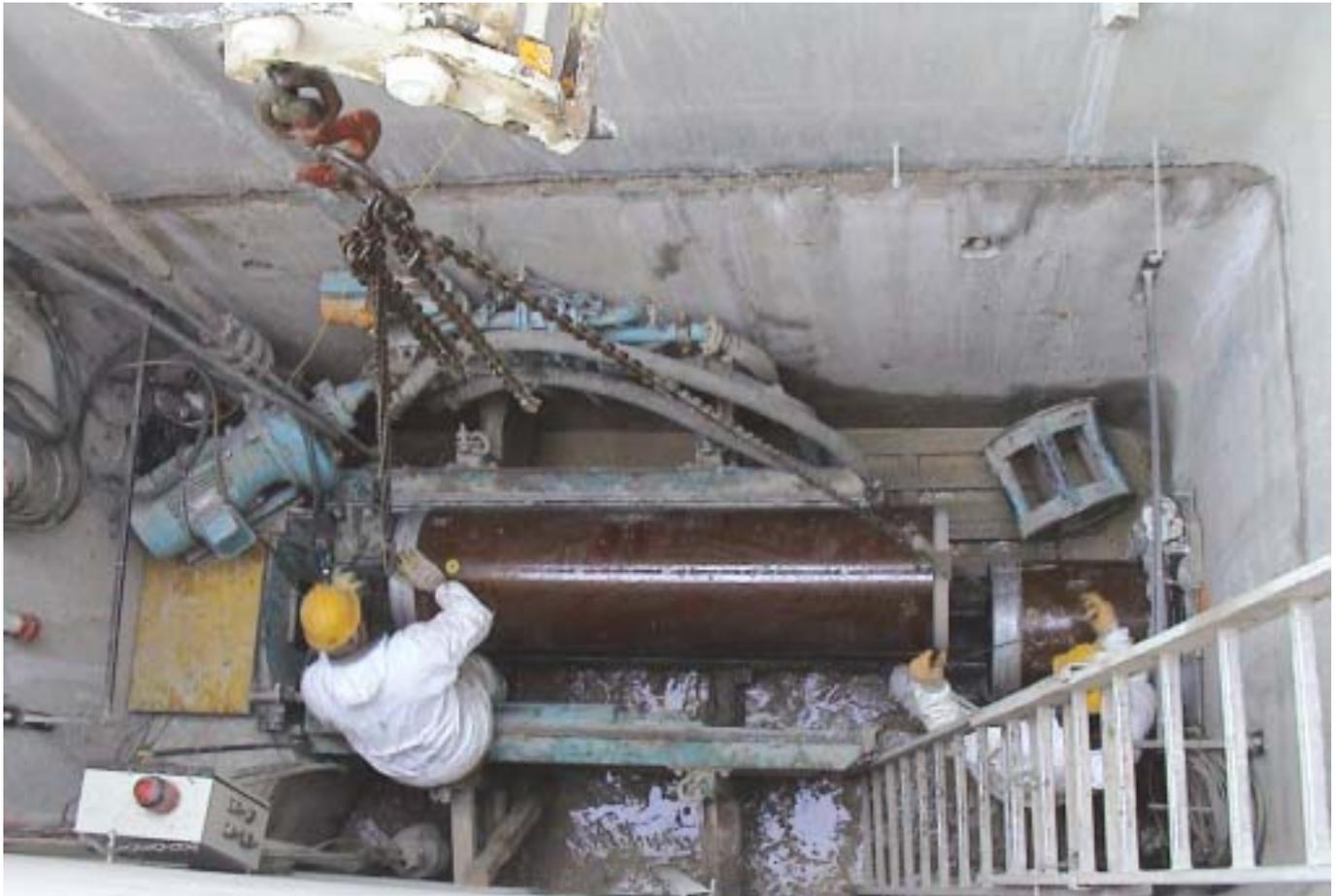
L'introduzione nel terreno di condotte posate senza apertura di scavi rappresenta la soluzione ideale: l'uso di sistemi di posa di condotte con tecniche "no-dig" può risolvere il problema.
