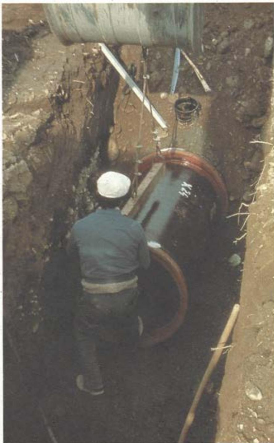
\* Fotografia n. 7 - Una fase dell'esecuzione del collegamento fra due tubi.
