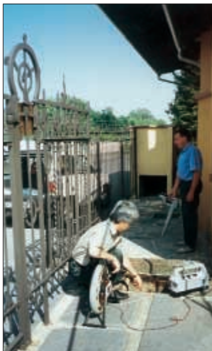
• Figura 1b - Sonda collegata ad asta flessibile rilevabile ed al relativo generatore di segnali.... Ricerca con cerca servizi.
