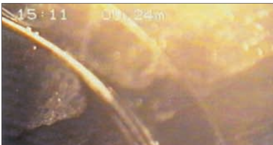
● Figura 9 - Scarico servizio igienico in "Geberit" Ø 110, ristagno d'acqua tra le due curve e possibile perdita.
