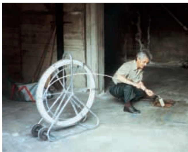
• Figura 3a-3b - Localizzazione con sonda (autonoma a batterie) di tubazione non conduttiva rilevato da cercaservizi.
