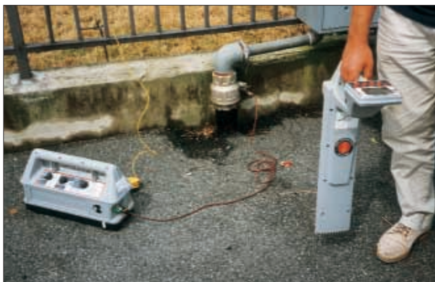
• Figura 2b - Ricerca di tubazione conduttiva con l'impiego di generatore in posizione CD (direzione di corrente), vedi display.
