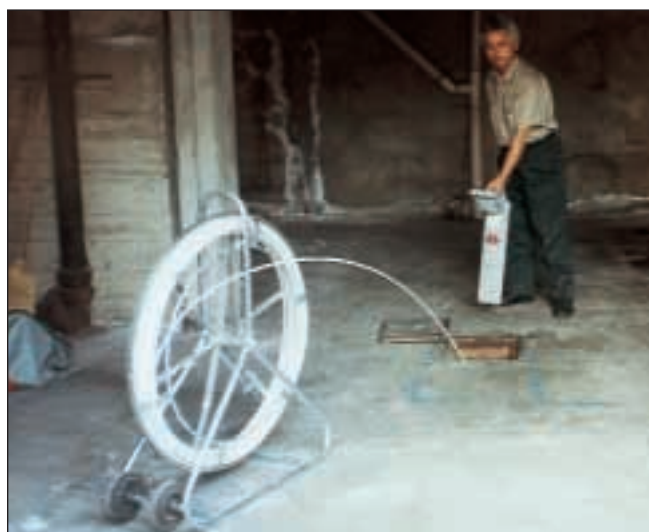
• Figura 3a-3b - Localizzazione con sonda (autonoma a batterie) di tubazione non conduttiva rilevato da cercaservizi.
