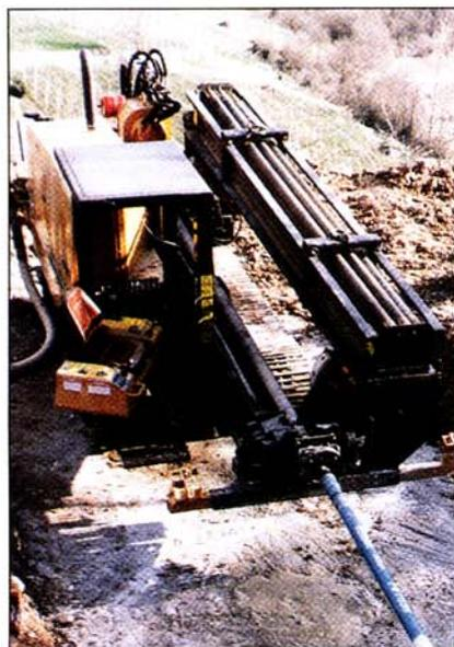
• *Figura 9 - Mori (Trento). Avanti le aste. Il tratto azzurro appena dietro lo scalpello contiene il motore a fango ed il rilevatore magnetico.*
