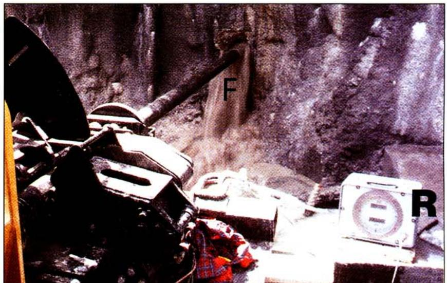
• Figura 17 - Racines (Bolzano). Scavo A di Figura 6 dove è posta ed opera la macchina perforatrice. Dal foro esce fango con frammenti rocciosi. Sulla destra visibile il quadro (R), collegato con la testa di avanzamento, con il quale è possibile controllare la posizione spaziale dello scalpello.
