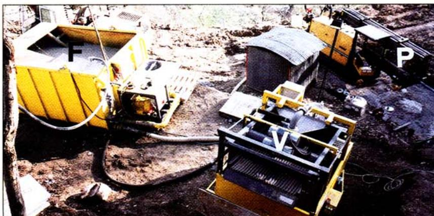
• Figura 8 - Mori (Trento). Cantiere per la perforazione. Visibile la macchina perforatrice (P) che serve anche per allargare il foro e trascinare il tubo, la vasca di perforazione dei fanghi (F) ed il vibrovaglio (V) che viene usato per separare i frammenti rocciosi dal fango di perforazione. Il fango viene poi passato nella vasca F.
