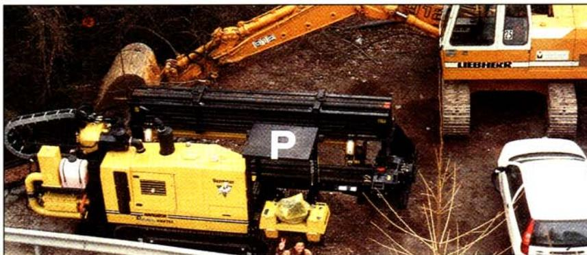
• Figura 7 - Racines (Bolzano). Macchina perforatrice (P) che serve anche per l'allargamento del foro ed il trascinamento del tubo; essa è in grado di operare fino a lunghezze di 500 m circa.
