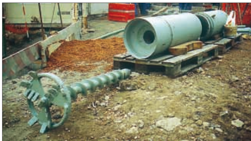
• Figura 6 - Testa di scavo prima dell'assemblaggio con fresa in primo piano.
