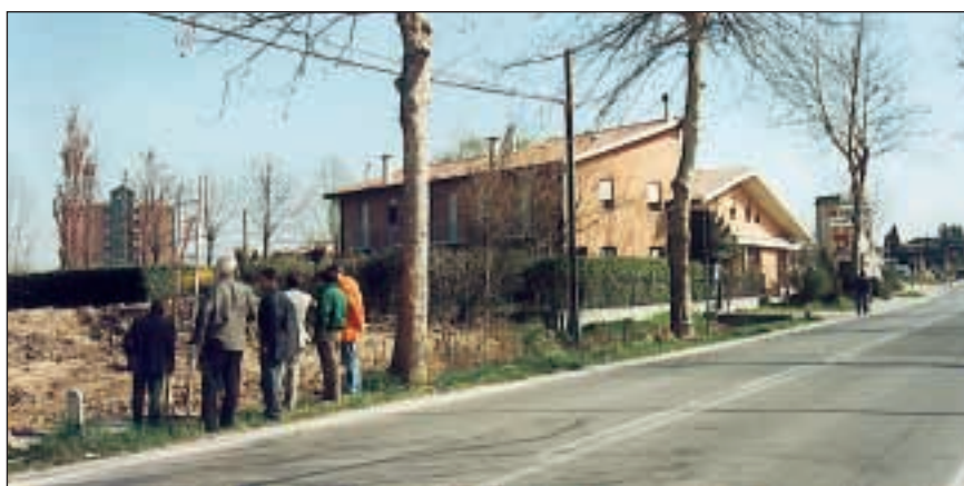
• Figura 13 - Area di intervento sulla S.P. n° 2 a lavori ultimati.
