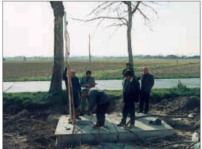
• Figura 12 - Operazioni di collaudo secondo DIN 4033 dal pozzo B.
