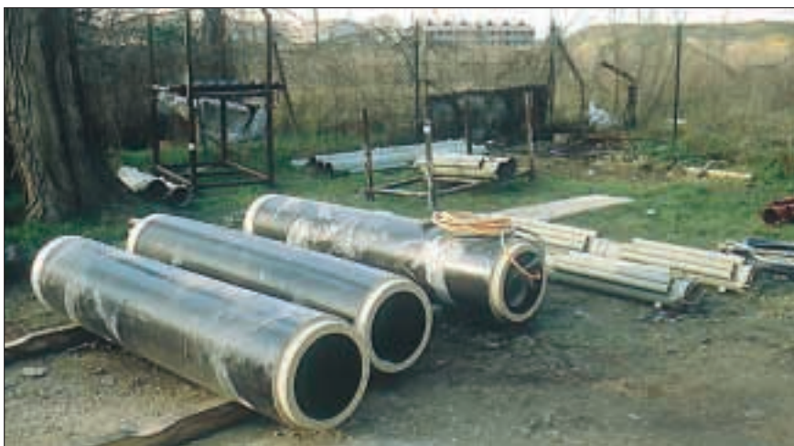
• Figura 1 - Tubazioni in gres DN 300 per posa con tecnica "microtunnelling".
