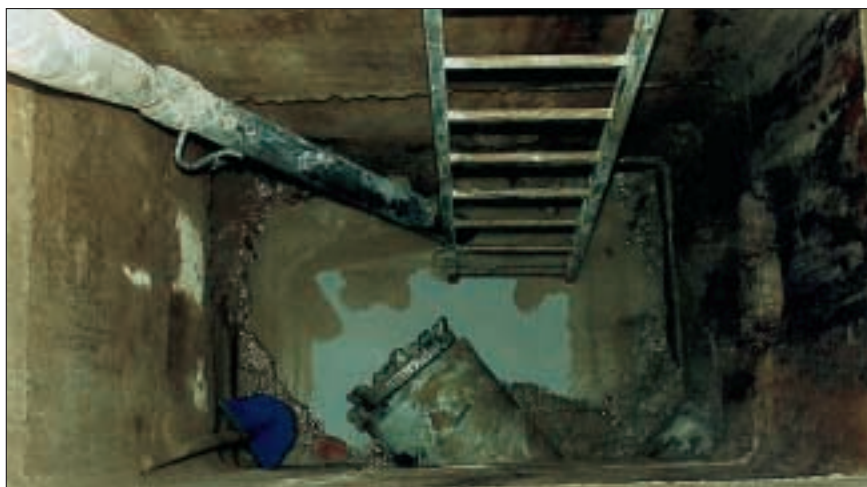
• Figura 10 - Arrivo della testa di scavo nel pozzetto esistente C.
