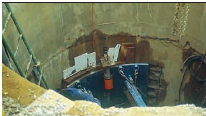
• Figura 4 - Apparecchiatura laser su pozzo spinta.
