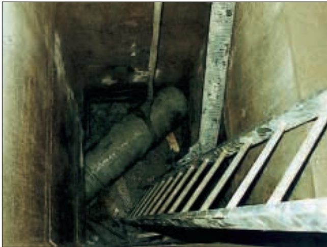
• Figura 11 - Recupero primo stadio della testa di scavo dal pozzetto C.
