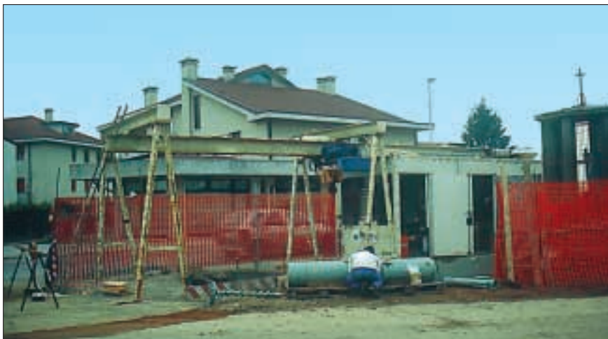
• Figura 3 - Particolare impianto di cantiere con container da 20' e carro ponte.
