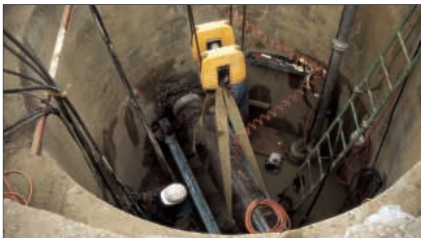
• Figura 9 - Posizionamento della tubazione sul ponte di spinta.
