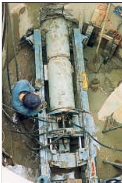
• Figura 5 - Infissione della testa di scavo.
