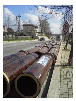
Un intervento di particolare rilevanza è stato quello che ha previsto l'installazione di un nuovo collettore fognario in gres del DN 500 a servizio della zona Mura Megalitiche dell'abitato.
