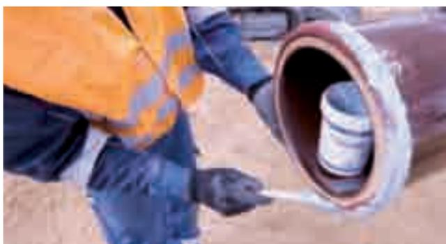
Nelle figure soprastanti viene mostrato come lubrificare la guarnizione.
