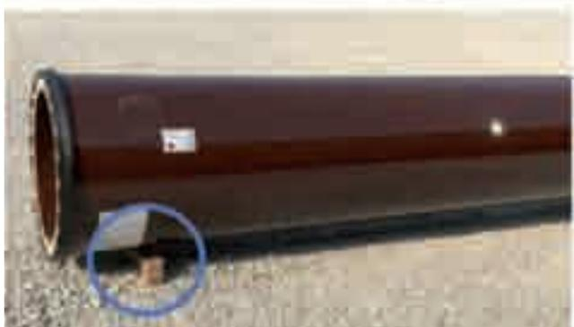
In figura si vede la corretta movimentazione con le fasce di nylon e come eseguire lo scarico temporaneo attraverso listelli di legno.
