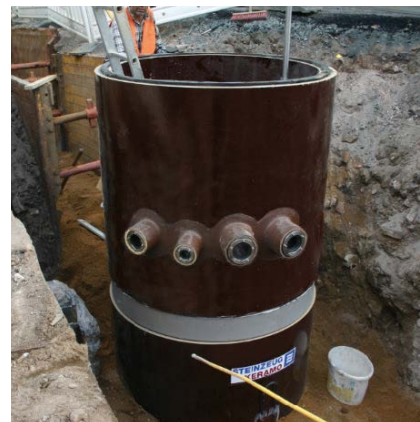
Pozzetto speciale con innesti per condotte di mandata sul rialzo
